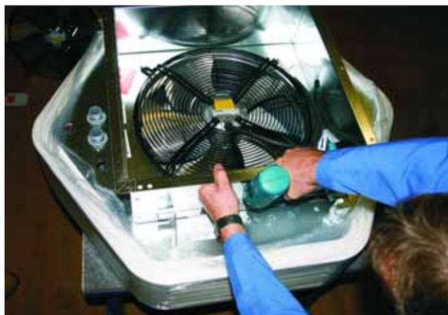
4: Montieren Sie den Anschlussrahmen mit Hilfe der mitgelieferten Schrauben. Die Kabeldurchführung muss gegenüber Vor- und Rücklauf liegen.
