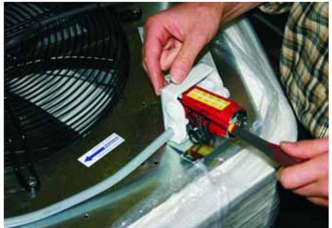
4: Schrauben Sie dann die metallene Grundplatte des Reparaturschalters ab.
