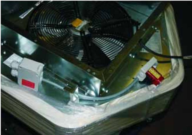
**13:** Positionieren Sie Klemmenkasten und Reparaturschalter auf dem Gerät.
