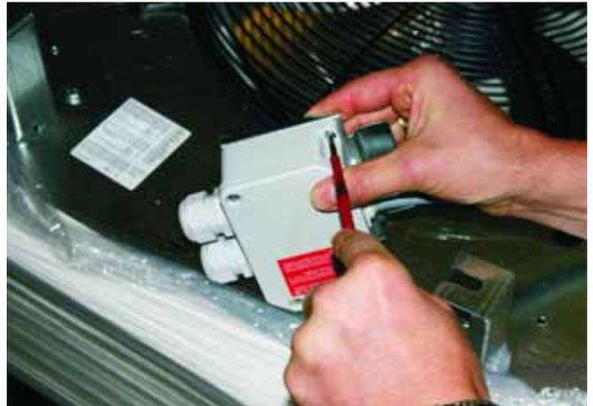
**8:** Entfernen Sie die metallene Grundplatte des Klemmenkastens indem Sie die Schrauben lösen.
