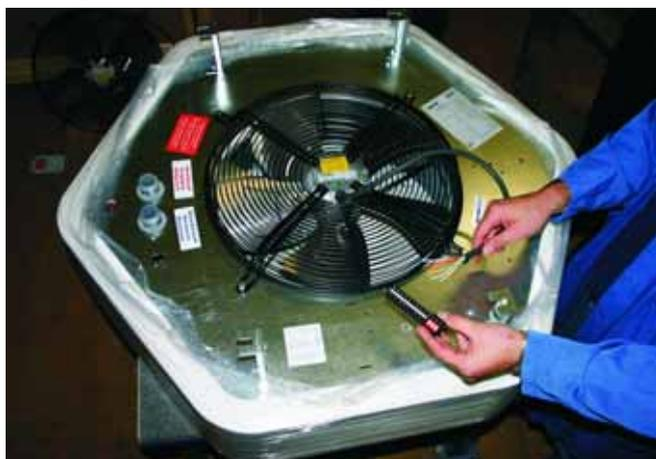
3: Demontieren Sie den Klemmenkasten und lösen Sie die Kabel von der Klemmenleiste.
