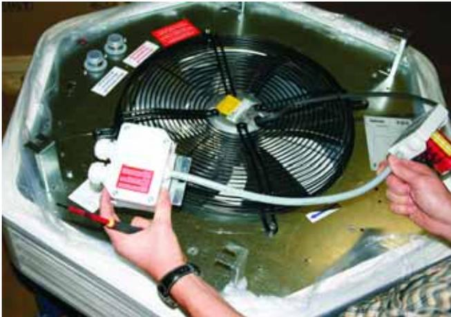
**7:** Reparaturschalter und Klemmenkasten demontiert
