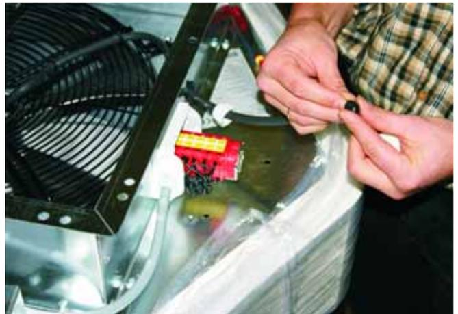
**16:** Schließen Sie das Elektrokabel wieder am Reparaturschalter an.
