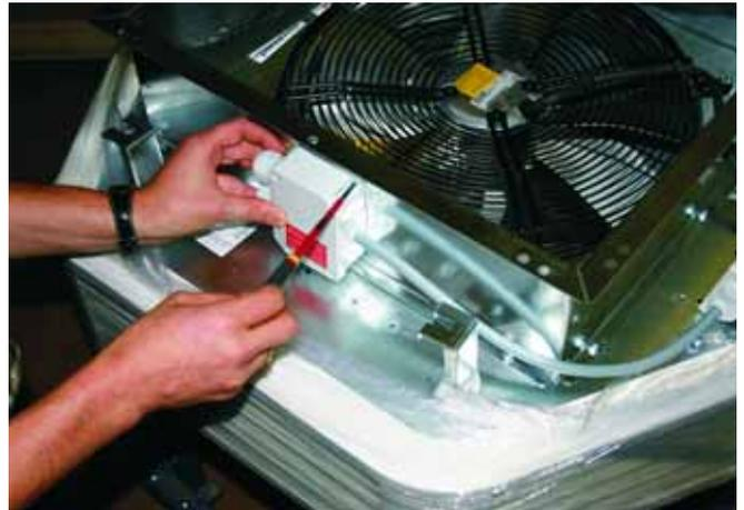
**14:** Montieren Sie den Klemmenkasten ohne die metallene Grundplatte am Anschlussrahmen. Verwenden Sie dazu die vorgebohrten Löcher.
