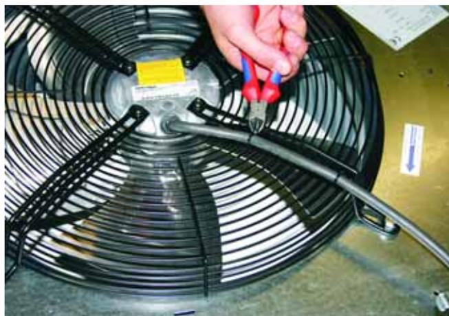
2: Zunächst lösen Sie das Kabel zum Klemmenkasten am Ultra.
