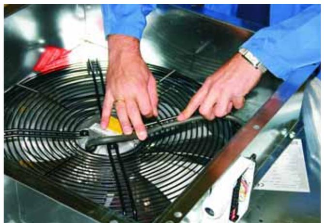
**12:** Befestigen Sie das Elektrokabel mit Kabelbindern an einer der Hauptstreben des Motorschutzkorbs; ggfs. Deckel des Klemmenkastens wieder festschrauben
