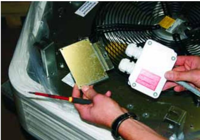
**9:** Demontierte Grundplatte des Klemmenkastens
