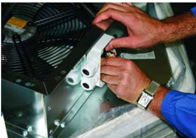
**11:** Montieren Sie die Klemmen im Klemmenkasten.
