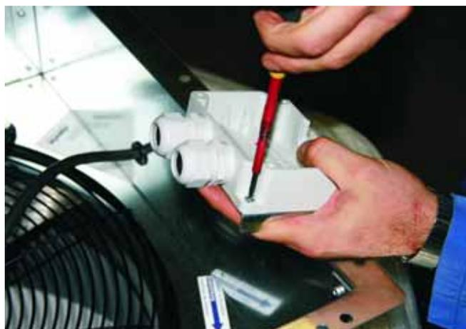
6: Lösen Sie die metallene Grundplatte des Klemmenkastens, indem Sie die Schrauben herausdrehen.
