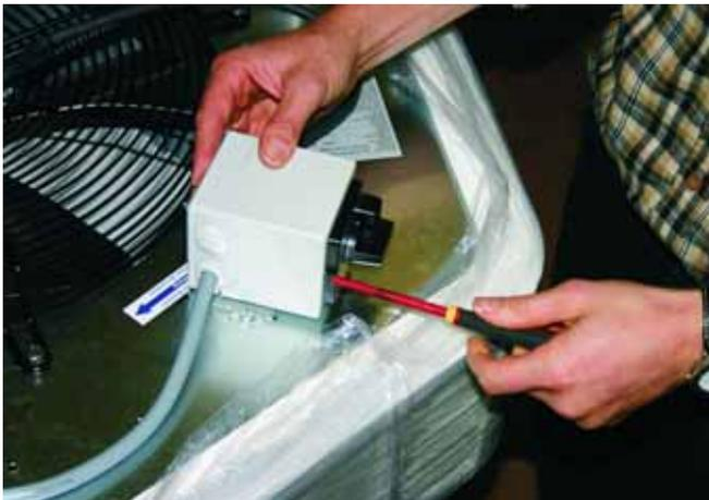
3: Demontieren Sie den Reparaturschalter indem Sie zunächst das Gehäuse durch Lösen der Schrauben entfernen.
