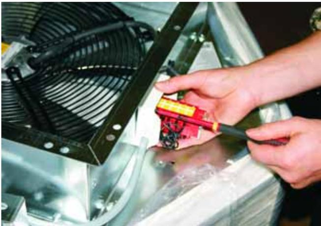
**15:** Montieren Sie den Reparaturschalter ohne die metallene Grundplatte. Verwenden Sie dazu die vorgebohrten Löcher und bauseitige Blechschrauben 3,9 x 13 mm.
