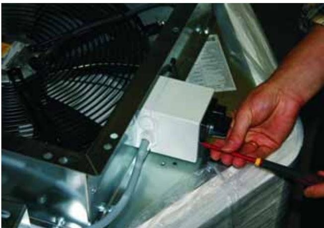
**17:** Montieren Sie das Gehäuse des Reparaturschalters.
