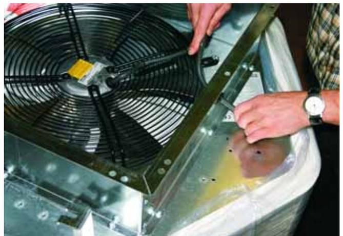
**12:** Ziehen Sie das Elektrokabel durch die Kabeldurchführung im Anschlussrahmen.
