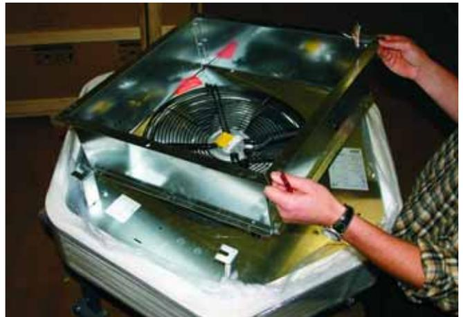
**10:** Setzen Sie dann den Anschlussrahmen auf die Oberseite des Geräts auf. Die Kabeldurchführung muss gegenüber Vor- und Rücklauf liegen.
