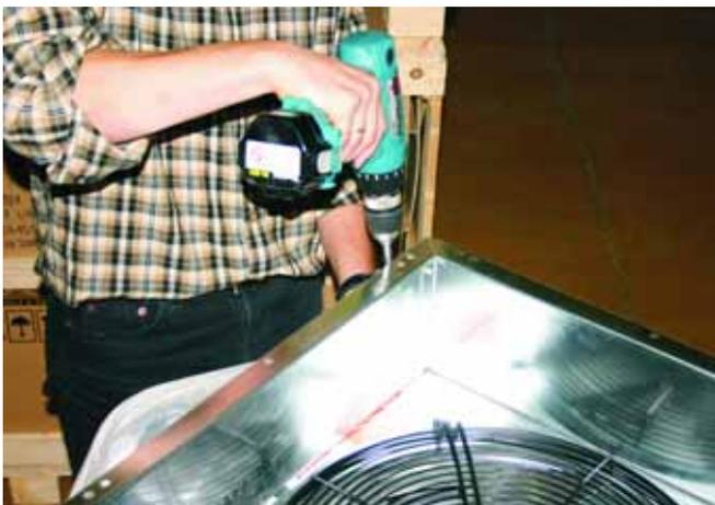
**11:** Schrauben Sie den Anschlussrahmen fest mit Hilfe der mitgelieferten Schrauben.
